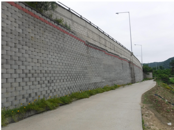
옹벽 기초 및 지반현황
