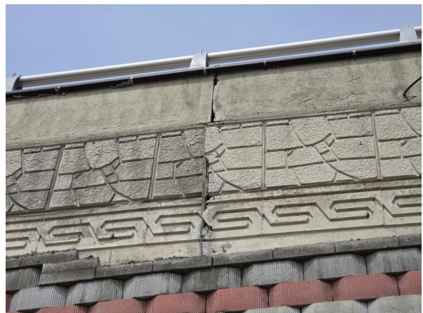
옹벽 상단 구조물 전경
