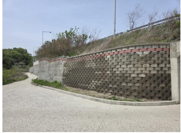
종점부 전면 전경
