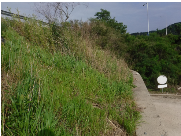
옹벽 상단 사면 전경
