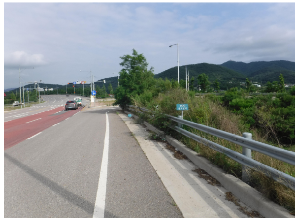
옹벽 상부 포장부 전경
