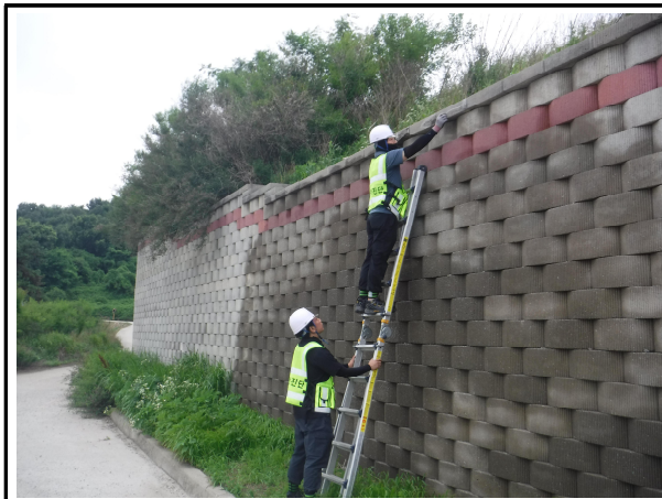
사다리를 이용한 현장조사
